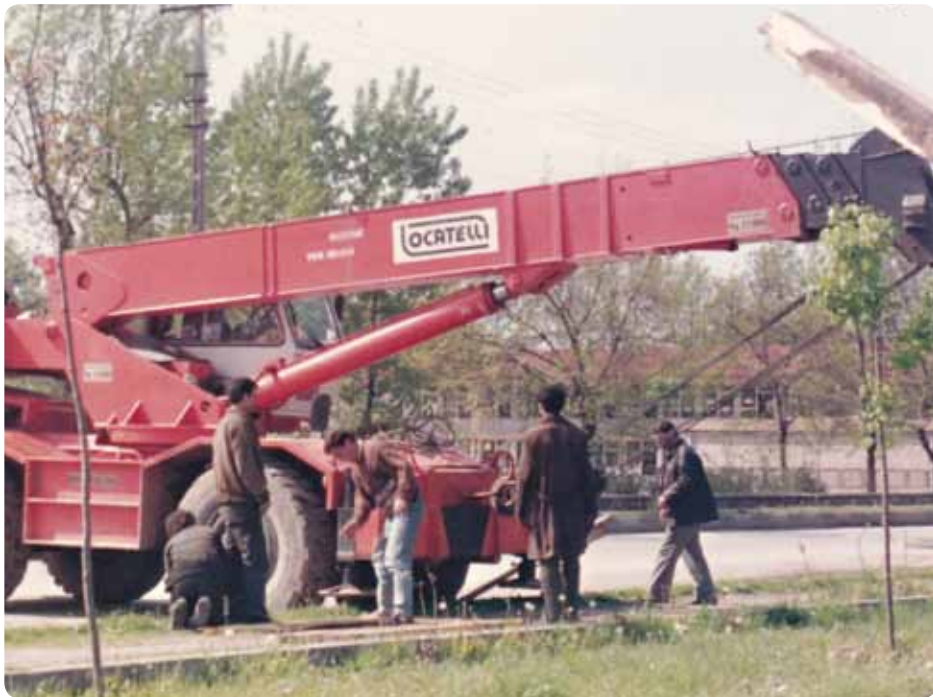
■ Подготовка на крана
